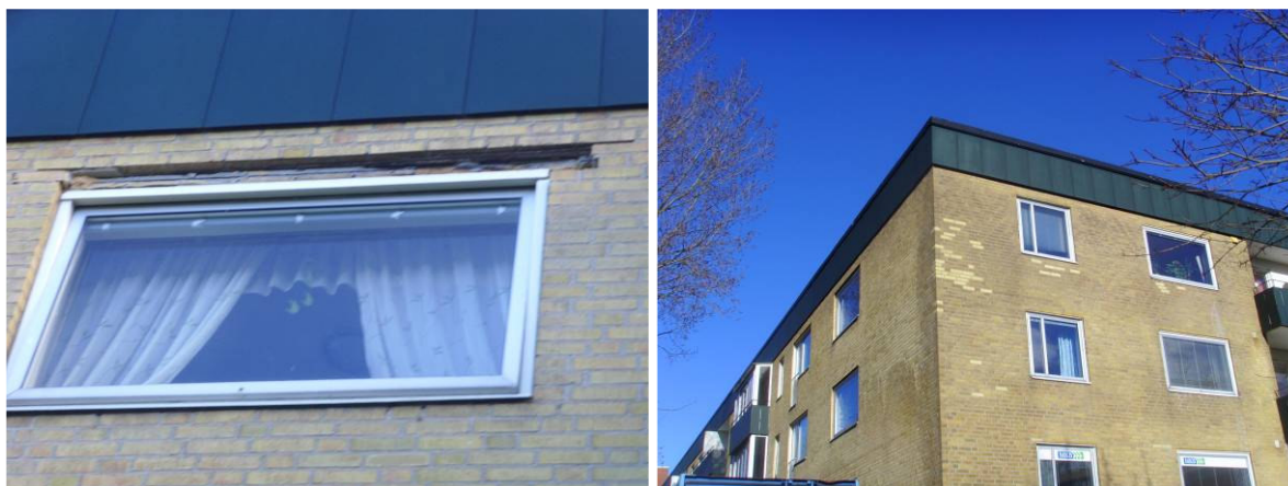
Figur 4.4 t v – ny balk monteras ovan fönster. T h – vissa tegelstenar har utsatts för frostsprängning och byts ut
