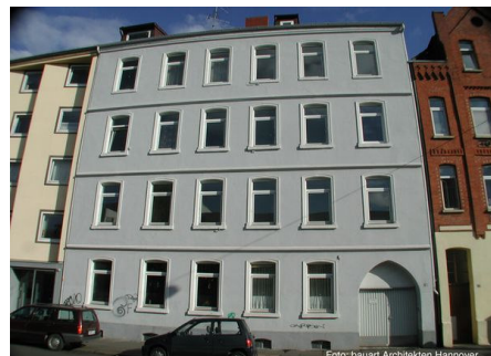
Bild: Straßenansicht vor der Sanierung, © Wohnungsgenossenschaft WOG Nordstadt e.G.
