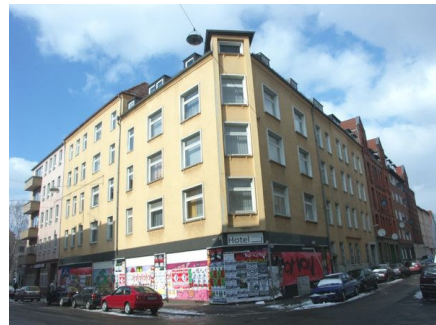
Bild: Före renovering © Dr. Ulrich Stiebel
