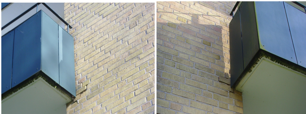
Figur 4.6 Sättningar vid balkonger
